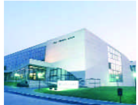
El seminario se desarrollará en las instalaciones del Hotel Balneario de Laias
